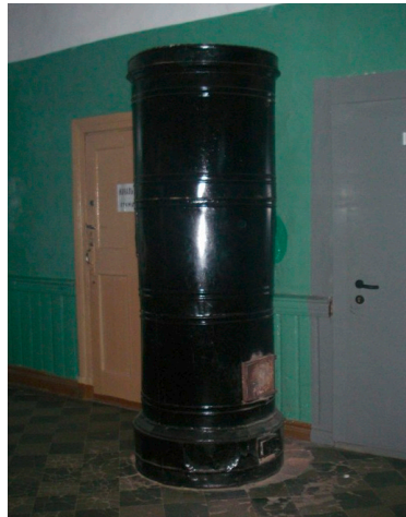
Печь Утермарка, современный вид, действующая модель
